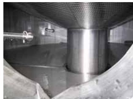
SimPulse 3C, вологе днище з інтегрованими бризговими циліндрами для очищення камери чистого повітря
